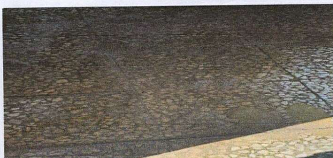
Sustitución de piso de granito, por piso de granito
