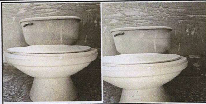
Sustitución de sanitarios con fisuras y sus accesorios
