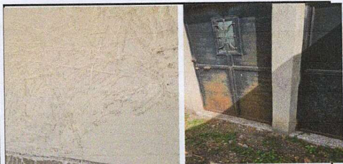
Reparación de Repello de muros interiores y exteriores, mantenimiento y reparación de puertas
