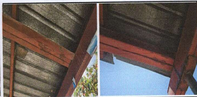
Mantenimiento a estructura portante y sustitución de lámina
