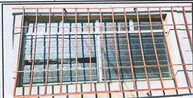
Sustitución de ventanas de paleta por ventanas de PVC y sustitución de balcones.
